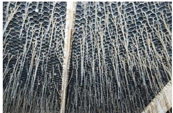
Bild 7-3: Wassereintrömseite sauber bzw. übermäßig verschmutzt
