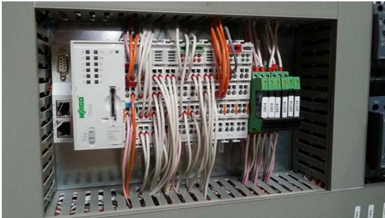
Bild 7-2: Datalogger mit SD-Karte im Schaltschrank
