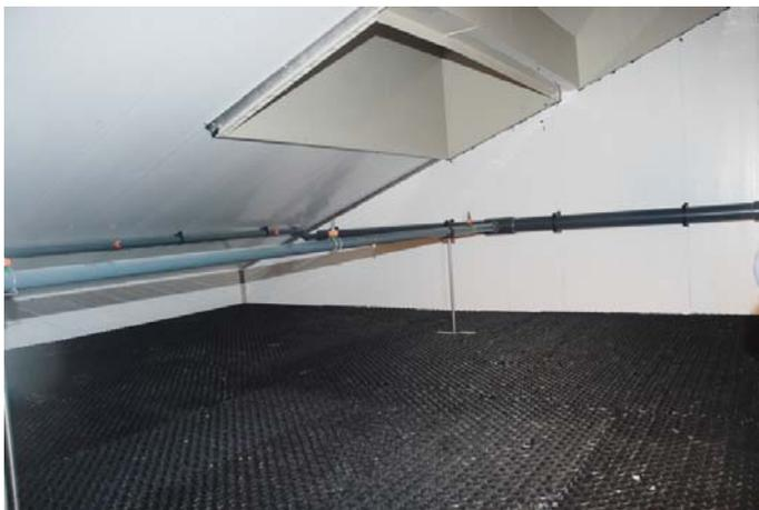
Bild 4-2: Filterpaket mit Sprühleitung
